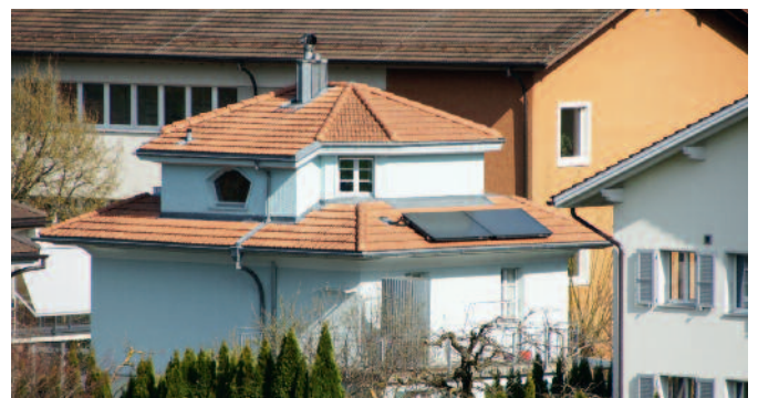
Solaranlage auf Neben-Dachfläche
